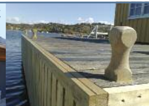
Nyoppført garasje, Onsøy
