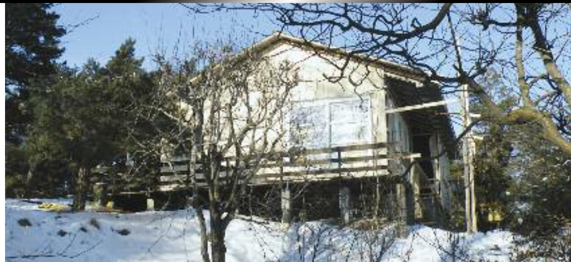
Hytte under oppføring på Kaholmen på Kråkerøy.
